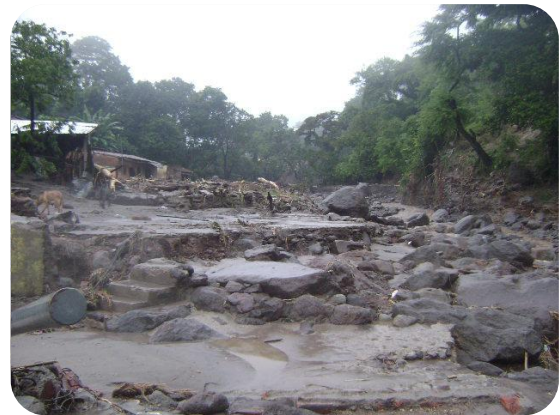
Fotografía N ° 11. Que muestra como algunas viviendas quedaron expuestas a mayor vulnerabilidad y por tanto alto riesgo.
