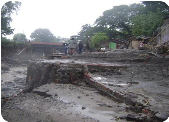
Fotografía N° 9. Situación similar a al anterior
